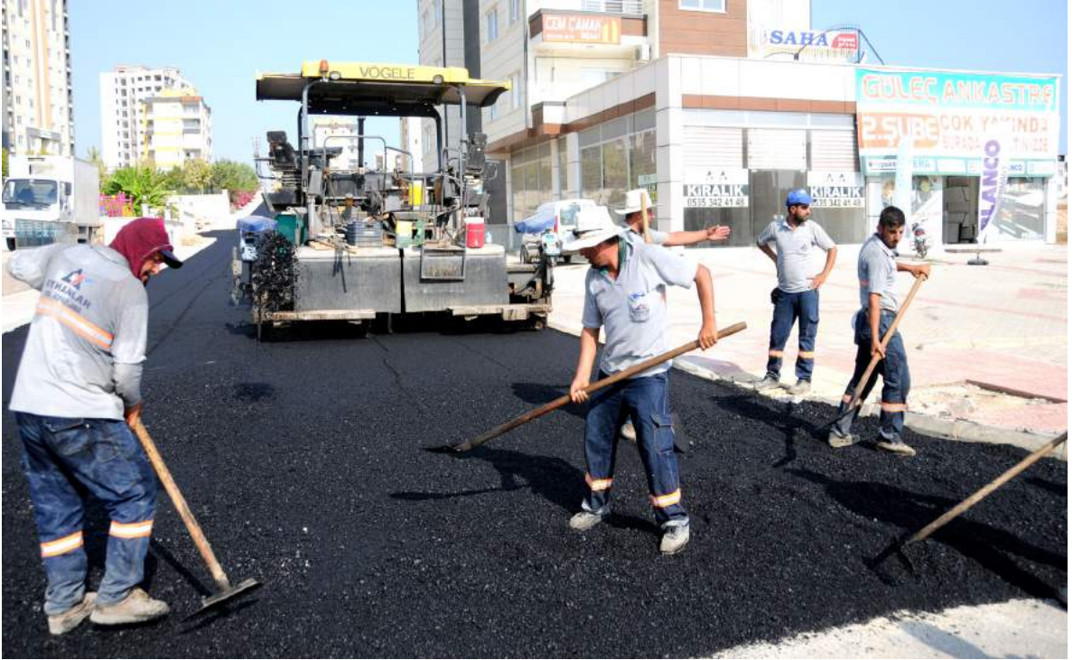
Asfalt Çalışmalarından Bir Görüntü
