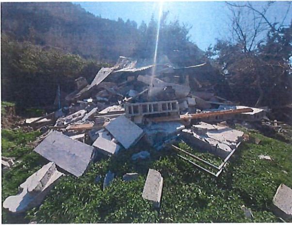
Şekil 3. Emirler Mahallesiinde heyelan nedeniyle hasar gören bağ evi
